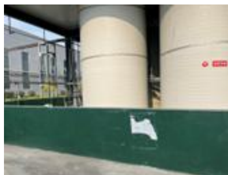
浓碱储罐区围堰
