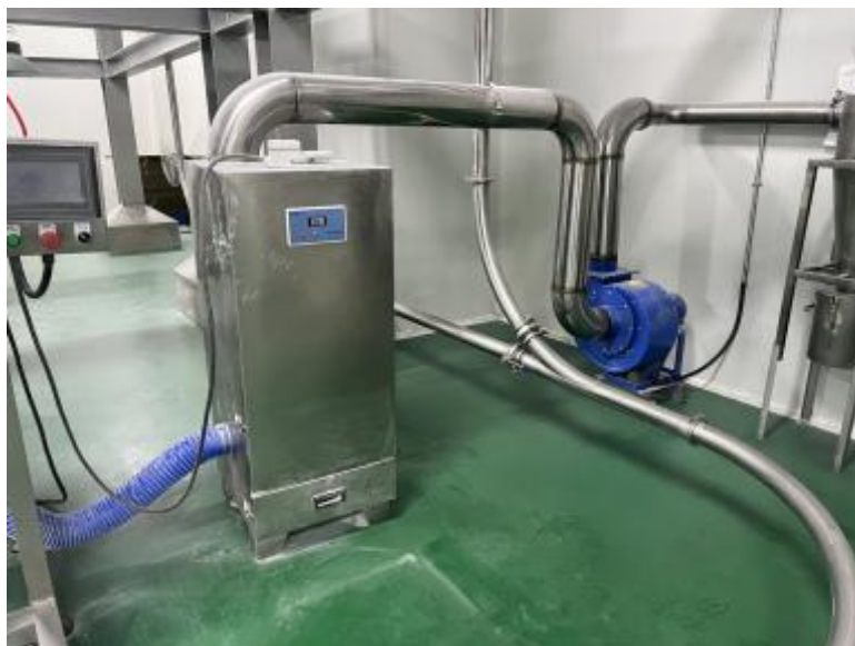
图 2.3-4 旋风分离+袋式除尘器现场图
