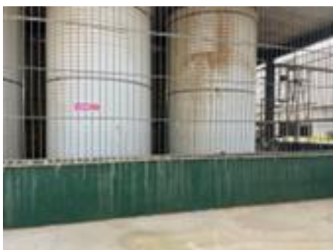
浓酸储罐区围堰
