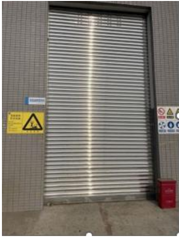
危险废物暂存间门口相 关标识
