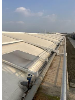
污水处理站加盖及次氯酸钠氧化+碱液喷淋现场照片见下图
