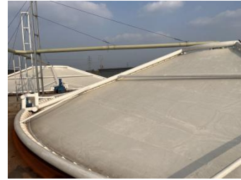
污水处理站加盖及次氯酸钠氧化+碱液喷淋现场照片见下图
