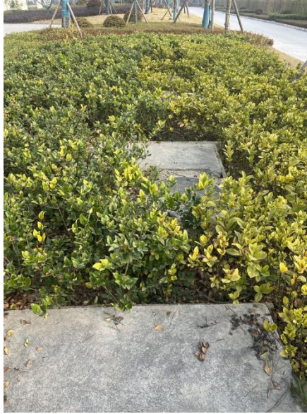
图 2.3-7 活污水预处理设施现场照片
